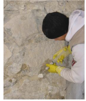
Fig. 16. Paramento originario cinquecentesco con giunti rifluenti: integrazione e consolidamento.
