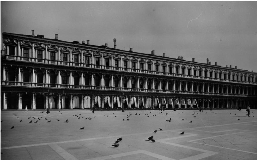
Fig. 6. Rispetto alle fotografie di epoca precedente, in questa ripresa del 1974 il fronte delle Procuratie appare schiarito dal dilavamento nelle zone non protette dagli aggetti. Non si osservano ancora percolature accentuate in corrispondenza dei cornicioni, che compariranno solo in epoca recente per il venir meno della manutenzione dei giunti (Archivio Fotografico del Museo Correr, foto Toso V18945).
